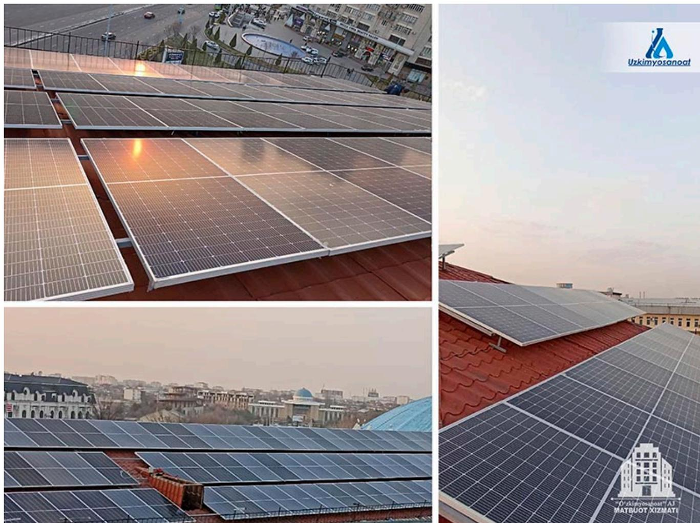
В здании АО «Узкимёсаноат» установлена и введена в эксплуатацию солнечная фотоэлектрическая станция мощностью 200 кВт·ч. По предварительным оценкам, станция будет вырабатывать 296 400 кВт·ч «зеленой» электроэнергии в год.
